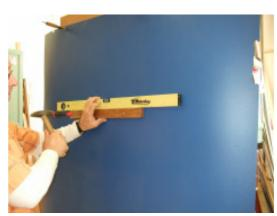
montageleiste von den beiden und sucht sich eine schöne Stelle an der Wand, wobei darauf zu achten ist das rechts vom Ende der Leiste (bei E-Gitarren gut 400-450mm) Platz bis zu einer Raumecke sein muss, weil nach rechts der Gitarrenhals herausragt, Höhe festgelegt und mit der Wasserwaage kontrollieren, dass es gerade wird. Mit einem kleinen Schraubendreher durch die vorgebohrten Löcher an der Wand Markierungen produzieren, an denen der 6mm Bohrer angesetzt wird.
